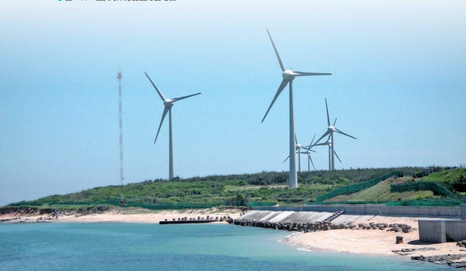
圖 4-14 位於海岸旁的風力發電機
